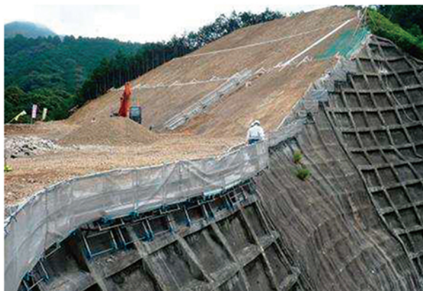
国土交通省 国道42号道路工事
