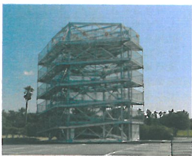
↑ 設置例: 静岡県御前崎市
