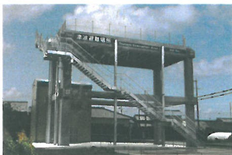
㈱ピーエス三菱 <新掲載>(158) P C a P C 工法による津波避難施設 Tel 03-6385-8030 (333F 津波避難用施設) 本誌35頁
