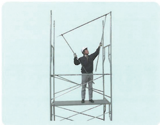
●メガプレスを大和式連結ピンに取付けます。
